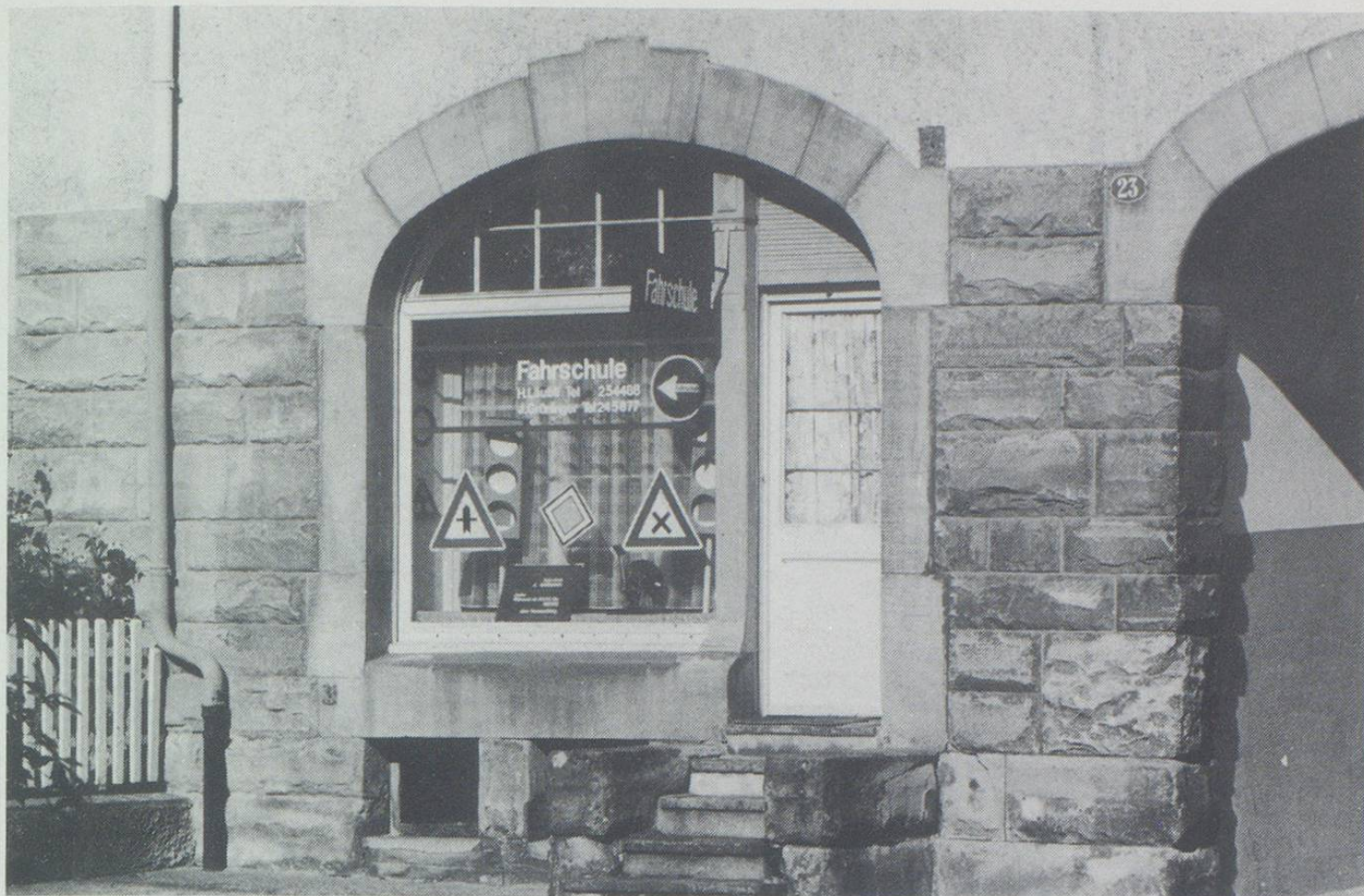
Ladeneinbau um 1909, von Emil Traber, Kolosseumstrasse 23
