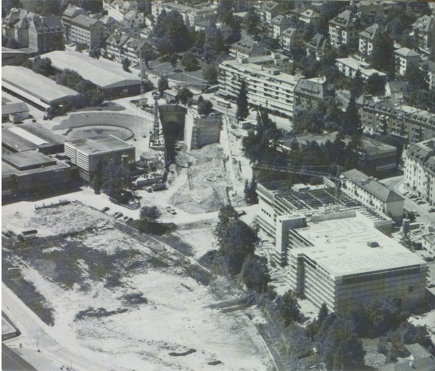
Zwischen St.Jakob-Strasse und Olma-Areal entsteht der östliche Teil des Rosenbergtunnels im Tagbau. Deutlich ist in der Bildmitte gleich neben der Arena die eine Röhre erkennbar; unten rechts die neue Olma-Halle auf dem ehemaligen Krämer-Areal.
