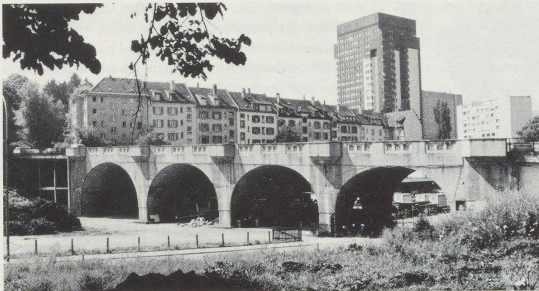
Die Lukasbrücke in den letzten Tagen, die dem Bau der NI weichen muss
