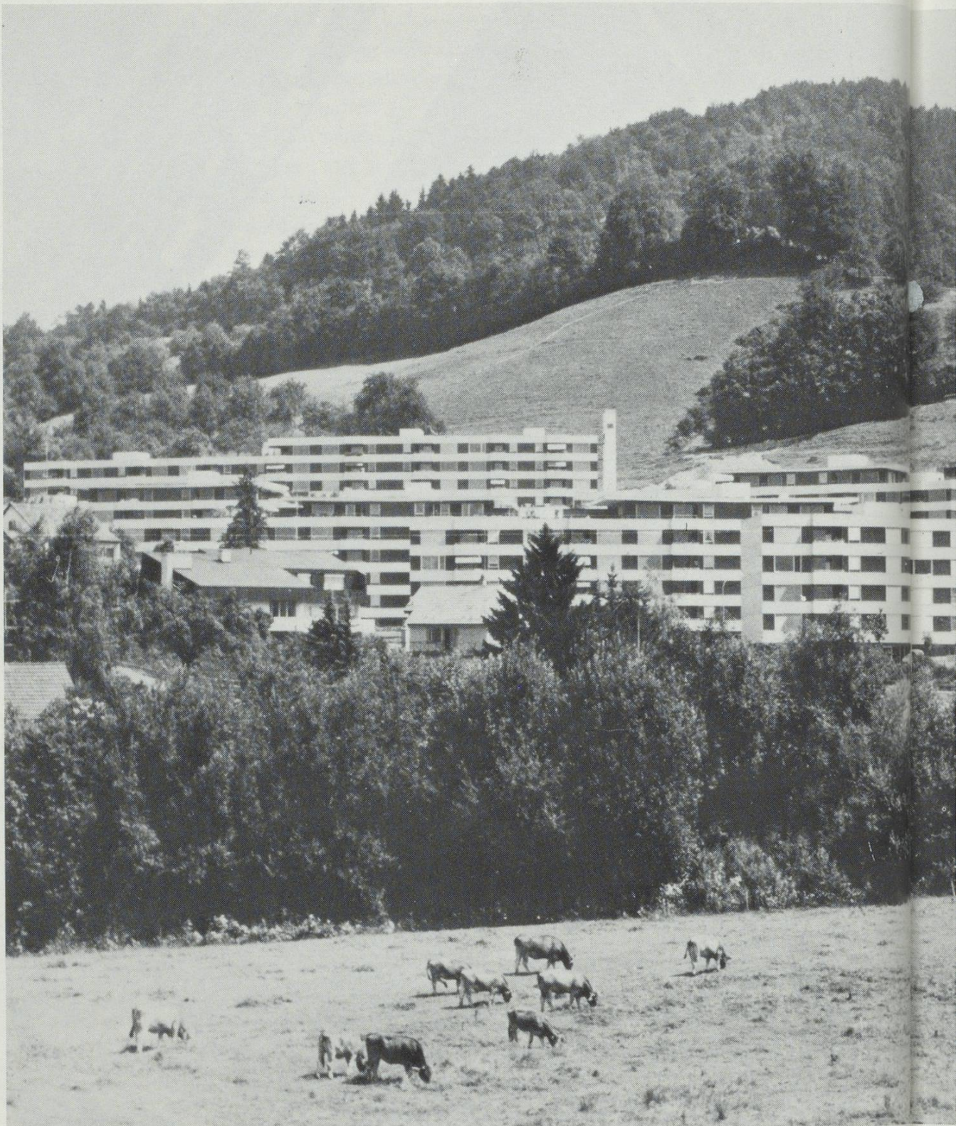
Die Grossüber- bauung im Haggenquartier.
