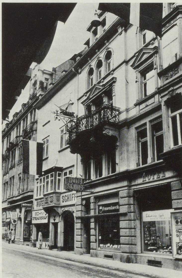
Das Hotel Schiff vor dem Abbruch
