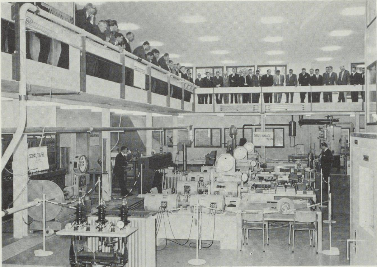
Das neue Elektrolaboratorium für das Abendtechnikum, dessen Erstellung dank Spenden von 36 Firmen der Privatwirtschaft möglich wurde.
