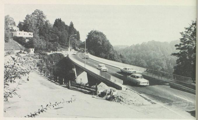
Auch im Osten der Stadt sind die Verkehrsverhältnisse mit dem Bau einer Brücke verbessert worden. Am 27. Juli 1965 wurde die Galgentobelbrücke dem Verkehr freigegeben. Sie weist eine überspannte Länge von 109 m auf.
