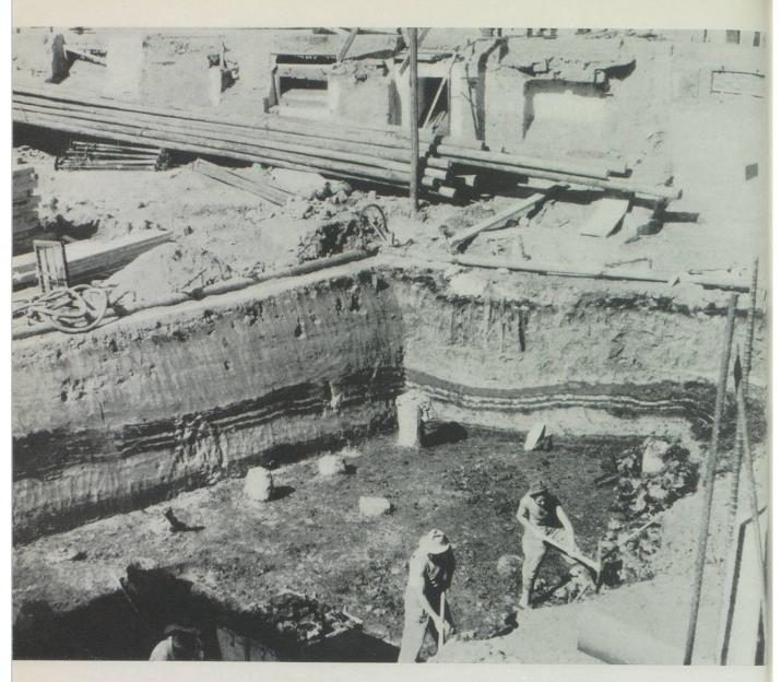
Torf in der Baugrube der Walhalla Am obern Rand Wellpointanlage zur Entwässerung der Grube
