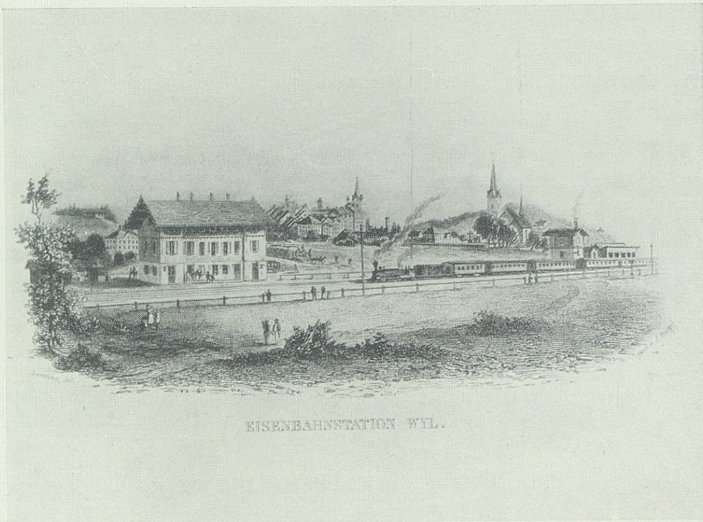
Der Bahnhof in Wil
