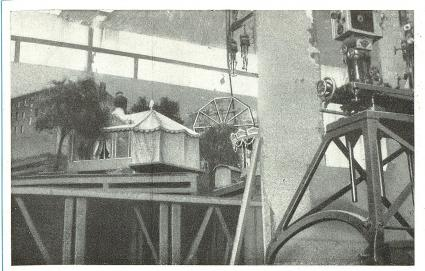
Der Modelltisch für das Schüfftan-Verfahren. Der Kopf des Mannes zwischen den Modellen gibt eine Vorstellung von deren Grössenverhältnissen. Rechts der Aufnahme-Apparat, der mit Wänden gegen störendes Licht verschalt wird.
