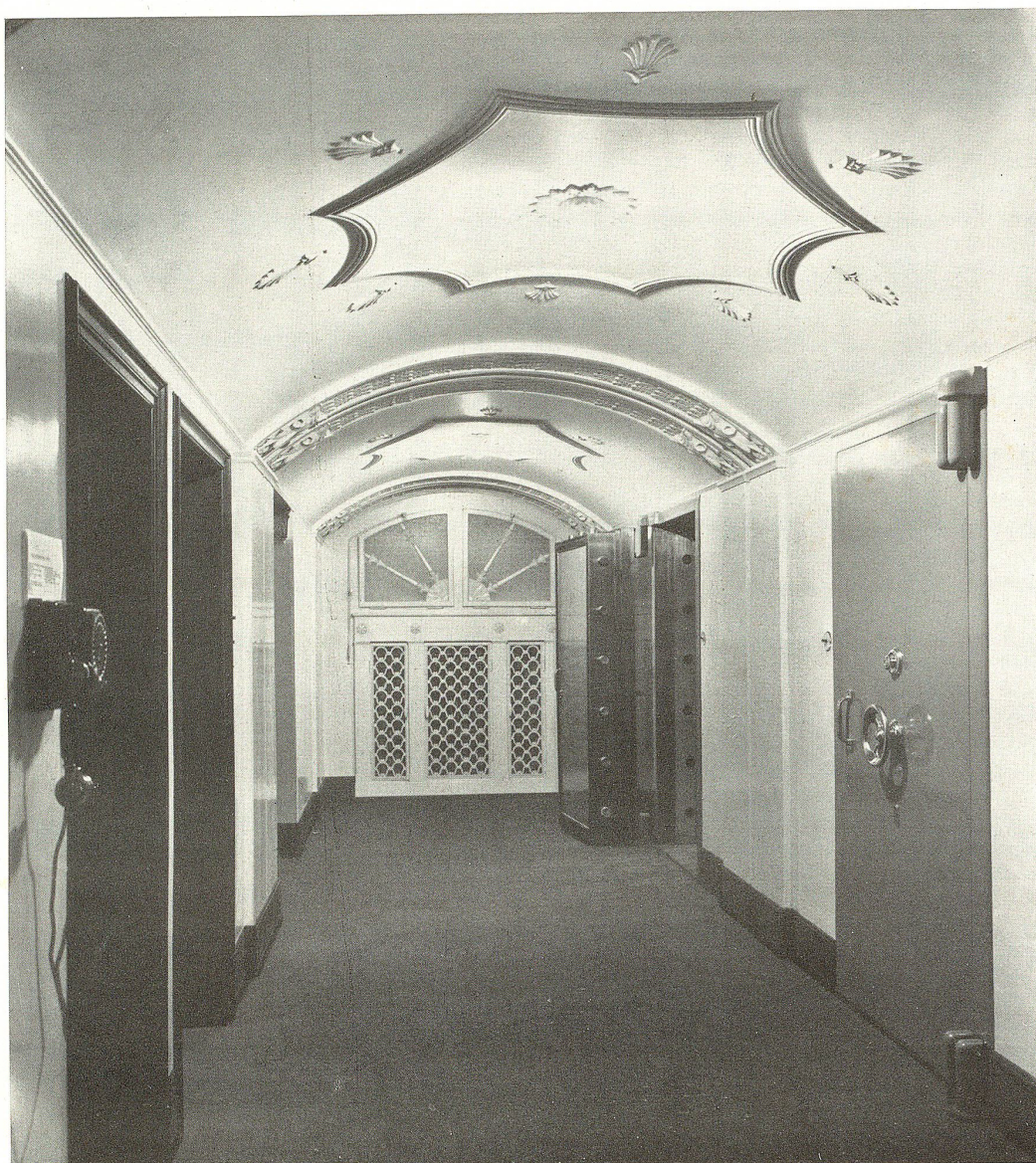
Panzer-Gewölbe im Bankgebäude St. Leonhardstrasse 33, Bank- und Kunden-Tresor
