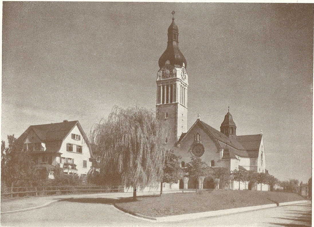
Die neue Marienkirche in Neudorf.
