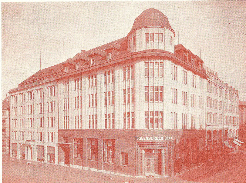
Ecke Kornhausstraße - St. Leonhardstraße
