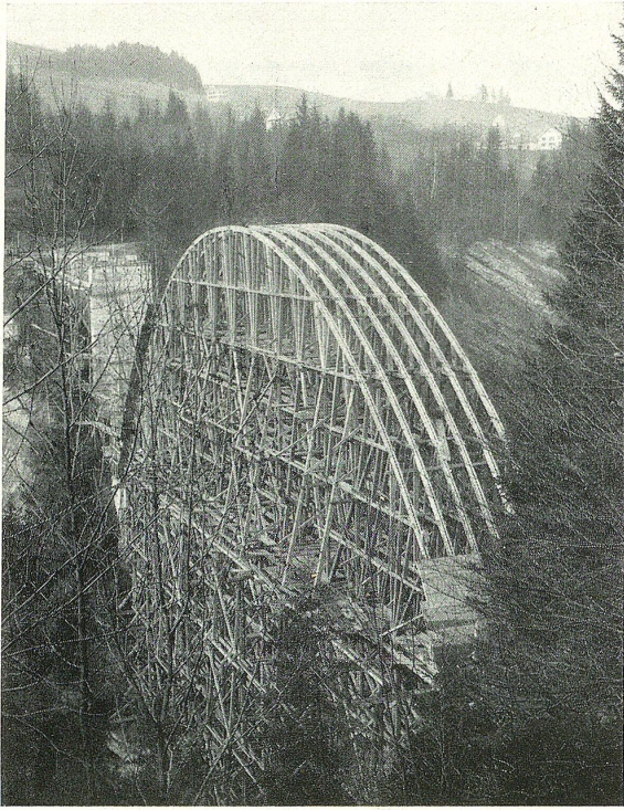
Leergerüst für den Hauptbogen der Brücke.
