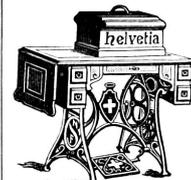
Einfach solid, billig Schwingschiff Centralspuhle Vor- und rückwärts nähend
