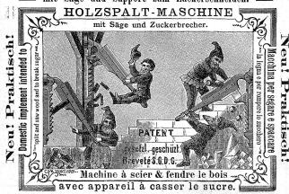
Dieser Apparat dient sowohl zum Holzspalten und Sägen in der Küche, als zum Zuckerschneiden, arbeitet gefahrlos ohne Schlag und vermeidet jede Beschädigung des Küchenbodens. — Preis per Stück Fr. 10 ohne Säge, Fr. 12 mit Säge. Wiederverkäufern Rabatt. – Grosses Lager.
