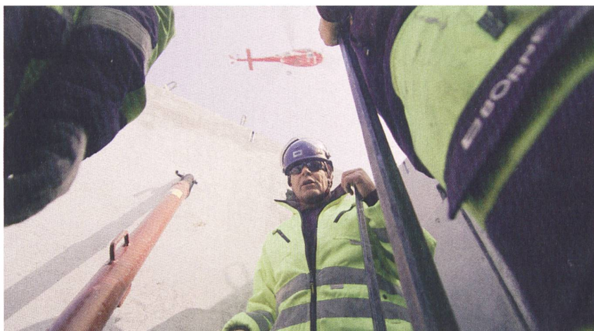
BORNERs hochalpine Monteure behielten stets einen kühlen Kopf.
