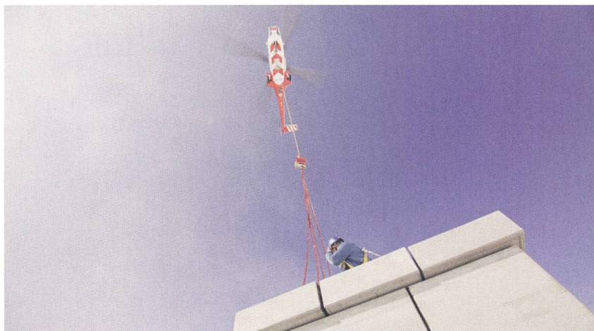
Die Schwergewichte positionierte der Super Puma von HELISWISS millimetergenau.
