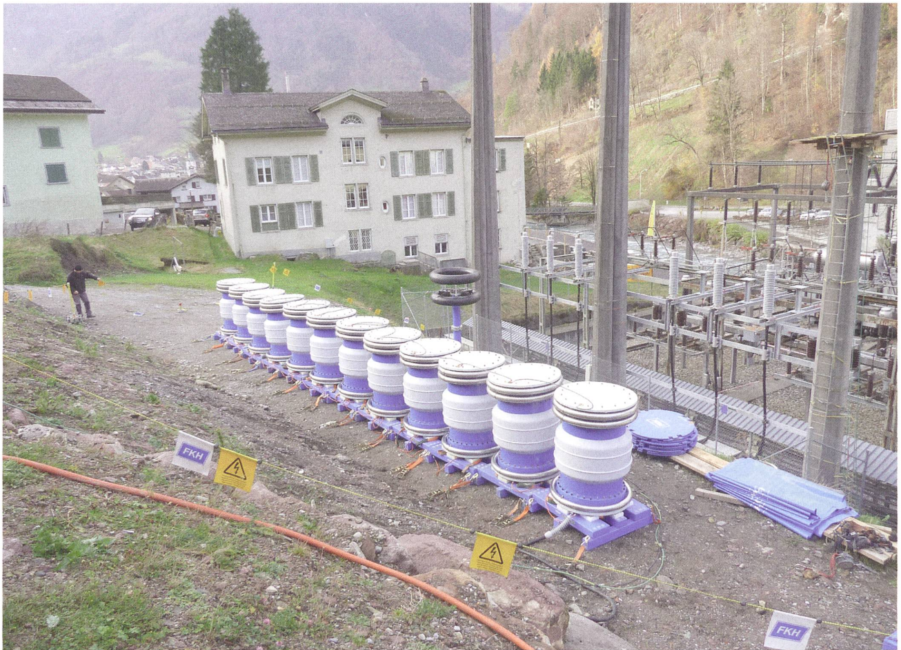
Kabelprüfung an einem 110-kV-Kabelsystem.
