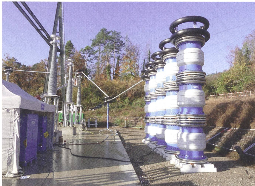
Bild 1 Beispiel einer Kabelprüfung durch die FKH an einem 380-kV-Kabelsystem.
