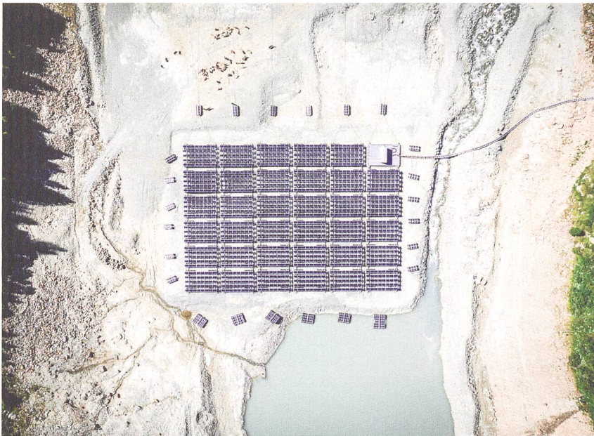
Figure 2 Quand le lac des Toules est vidangé, le parc flottant repose sur une plateforme constituée de matériaux de remblai dont la hauteur atteint près de 7 m par endroits.
