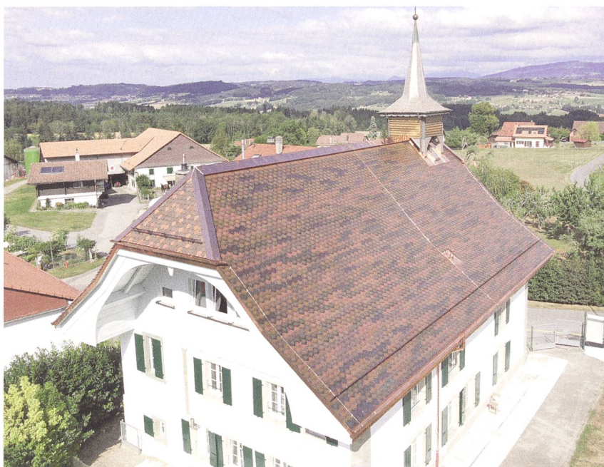
Figure 1 Des tuiles solaires de diverses couleurs terracotta, mixées, ont été intégrées au toit de l'ancien collège de Ferlens pour obtenir un rendu esthétique reproduisant celui d'un vieux toit en terre cuite.
