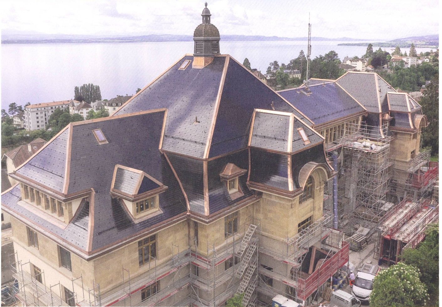
Des tuiles solaires ont été installées sur l'ensemble du toit du collège des Parcs, à Neuchâtel.
