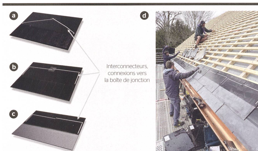
Figure 2 Nouvelle génération de tuiles solaires développées dans le cadre du projet Freestyle: a) tuile Classic, b) tuile Premium Black, c) tuile Heritage, et d) installation de tuiles Heritage sur un toit.
