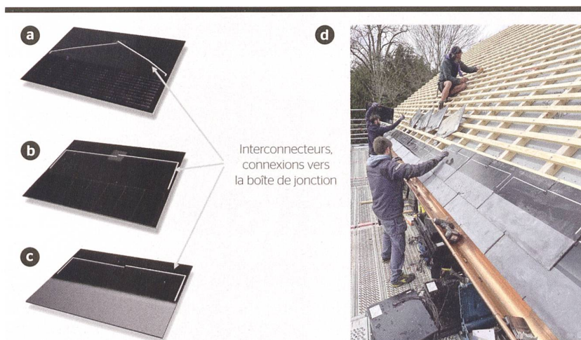
Figure 2 Nouvelle génération de tuiles solaires développées dans le cadre du projet Freestile: a) tuile Classic, b) tuile Premium Black, c) tuile Heritage, et d) installation de tuiles Heritage sur un toit.
