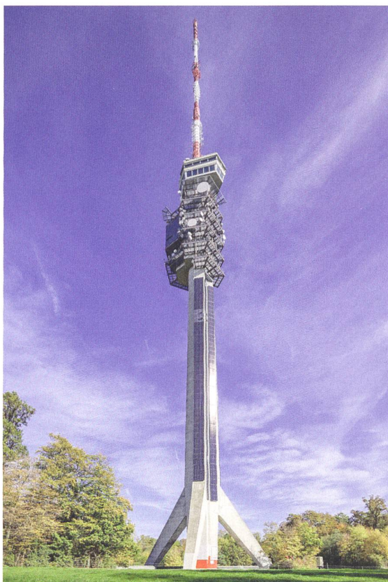
Vier Flächen des Turmschafts des 250 m hohen Sendeturms auf St. Chrischona wurden 2017 mit PV-Modulen ausgestattet.
