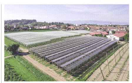
Bild 1 Teildurchlässige Struktur, die beispielsweise für Spalierobst geeignet ist.
