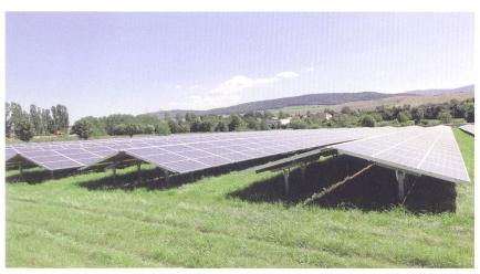
Bild 4 Der Klassiker: schräg aufgeständerte Freiflächensysteme.
