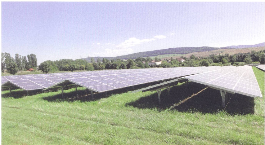
Bild 4 Der Klassiker: schräg aufgeständerte Freiflächensysteme.
