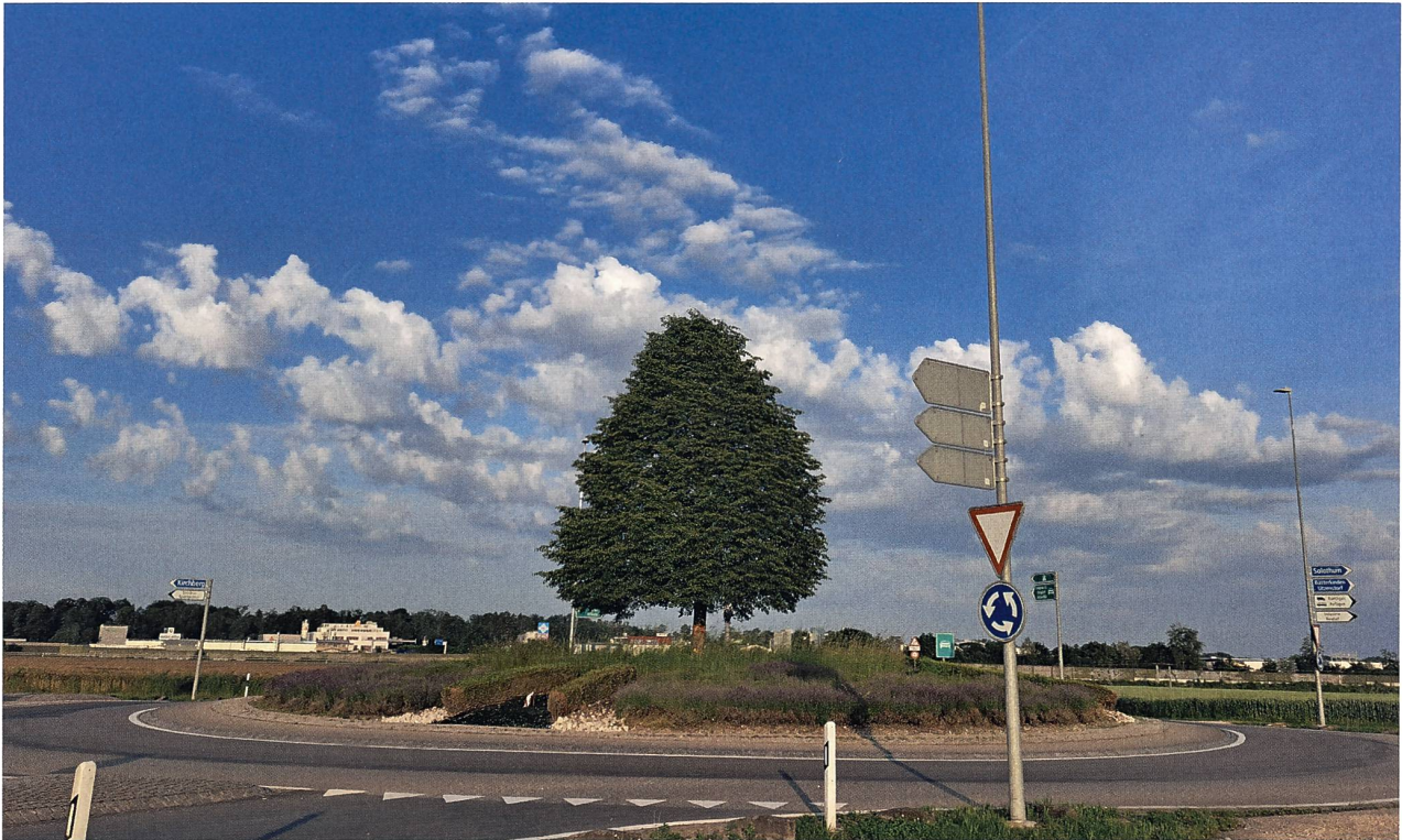
Kandelaber werden oft für das Anbringen von Strassenschildern benutzt.
