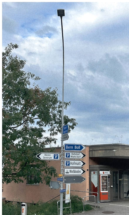
Strassenschilder werden schnell zu einem Problem: Ein zusätzliches Schild kann zu einer Überbelastung des Kandelabers führen.
