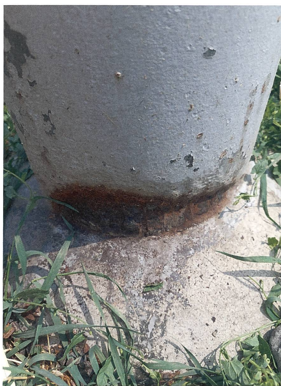
Eine Mastprüfung gibt Auskunft darüber, ob Korrosion die Standsicherheit beeinträchtigt.
