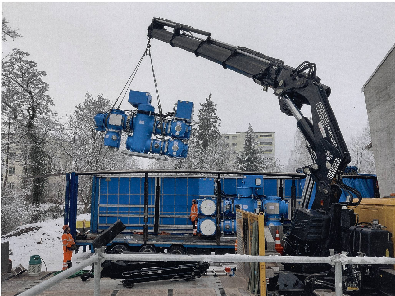
Ablad der BlueGIS für das Unterwerk Therwil im Dezember 2022.
