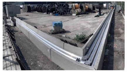
Figure 2 Câble à air comprimé moyenne tension (36 kV) avec trois phases juxtaposées, posé dans un canal de câbles.
