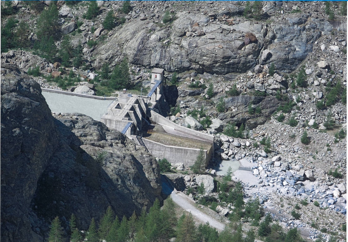
Wasserfassung an der Gornera (Zermatt VS) und anschliessende Restwasserstrecke.
