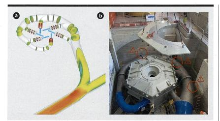
**Figure 3** a) Champ de vitesse de l'écoulement dans la bifurcation et le répartiteur, obtenu par simulation numérique en vue d'optimiser les performances au sein de l'espace disponible dans le bâtiment. b) Jeux réduits au minimum entre le répartiteur et le béton en place.
