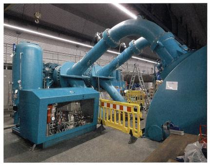
**Figure 1** Répartiteur du groupe 3 de la centrale de Veytaux I instrumenté durant la campagne de mesure de performances par la méthode thermodynamique.
