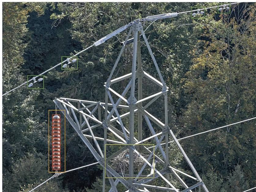
Outre les isolateurs, les programmes de détection des défauts peuvent également détecter les amortisseurs de vibrations (en vert) et les nids d'oiseaux (en jaune).
