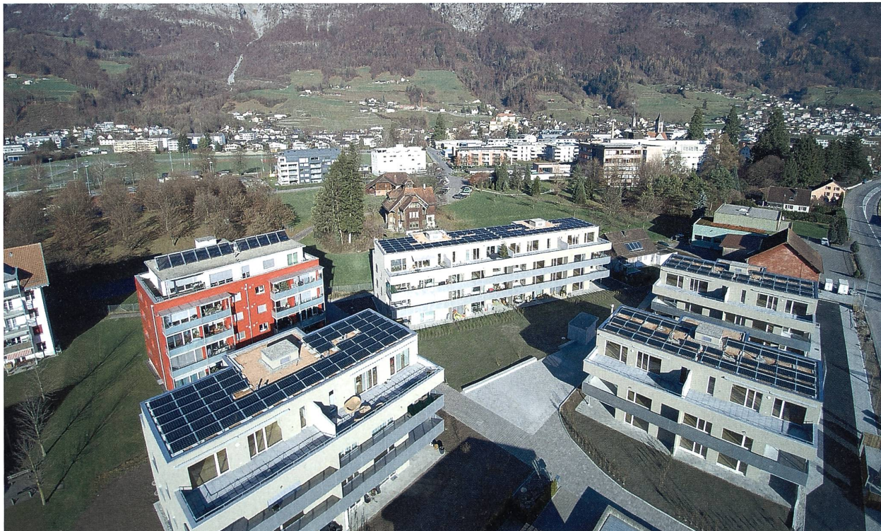
In Walenstadt wurde erstmals das Konzept von lokalen Elektrizitätsgemeinschaften getestet.
