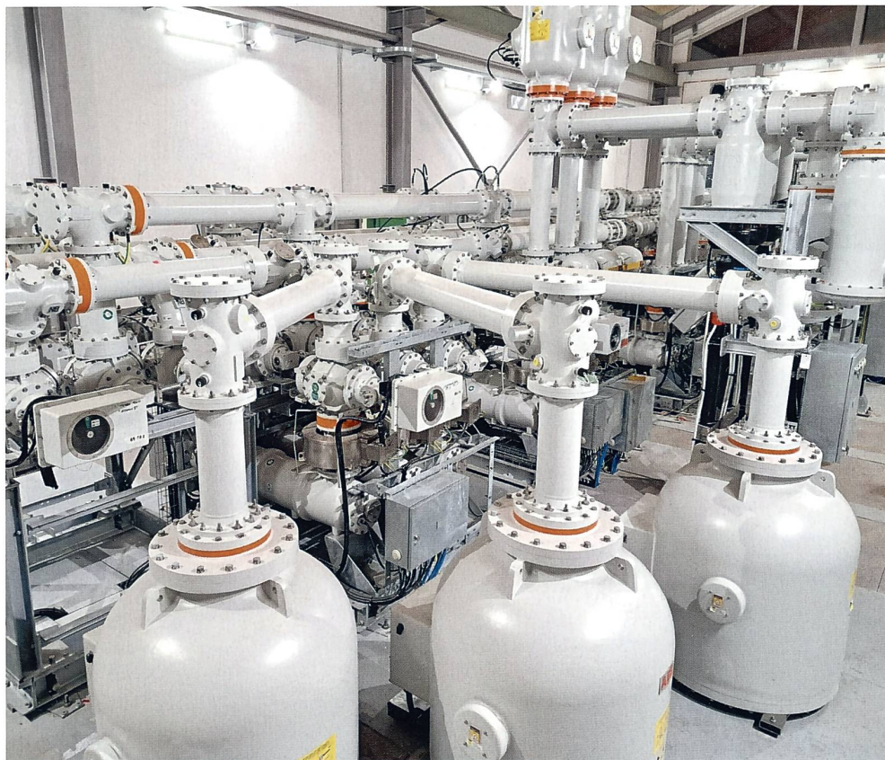
Typische GIS-Installation mit verschraubten Flanschen.
