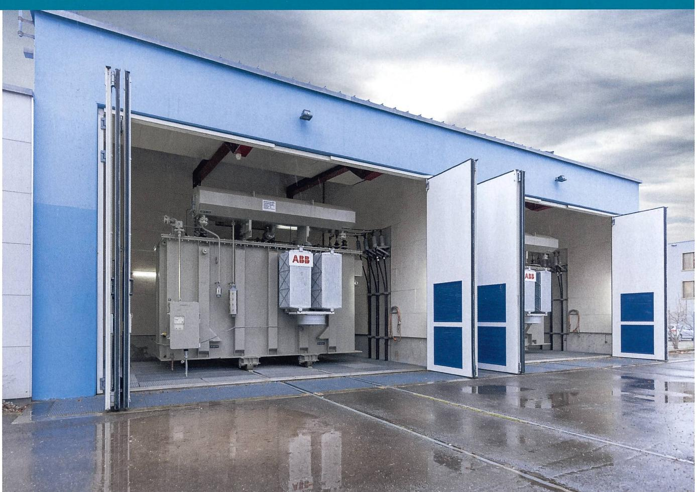
Transformateurs HT/MT de 25 MVA avec régulation dynamique de la tension secondaire.
