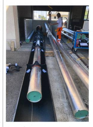
**Bild 2** Verlegung einer Anlage mit Rollensystem.
