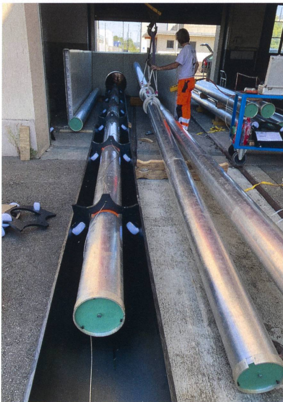
Bild 1 Da das System eine Verlegung mit Winkeln (Biegeradius 0) erlaubt, sind Installationen möglich, die mit Kabeln nicht realisiert werden können.
