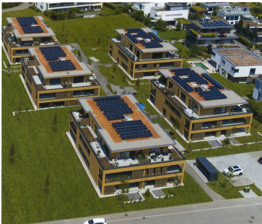
Wohnprojekt «Sirius» in Kreuzlingen: Hier durfte NeoVac unter anderem die Tiefgaragen mit der intelligenten Ladeinfrastruktur ausrüsten.
