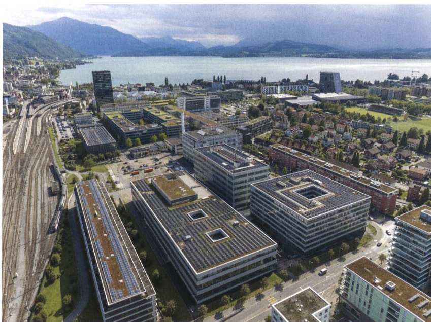
Installations photovoltaïques sur le Siemens Campus, à Zoug.
