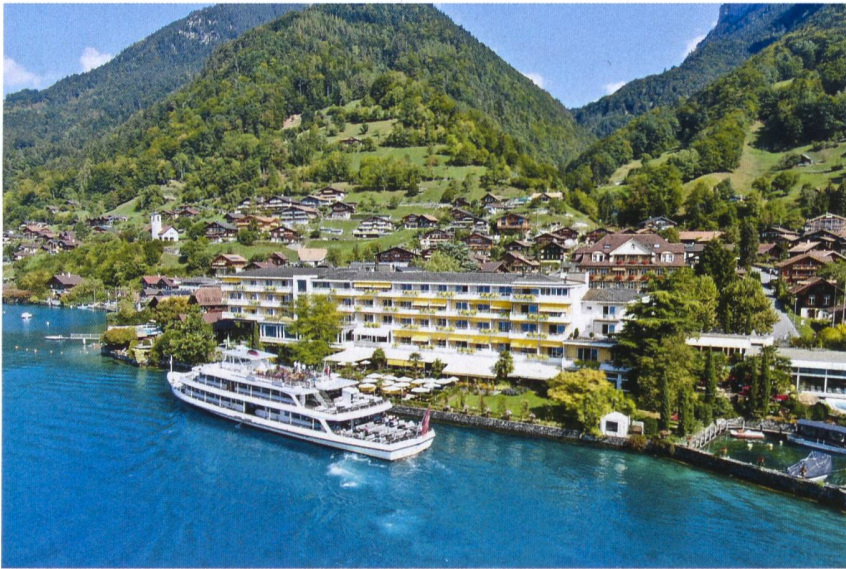
Dank Energiespar-Contracting reduziert sich der jährliche CO 2 -Ausstoss des Hotels «Beatus» um 719 t.
