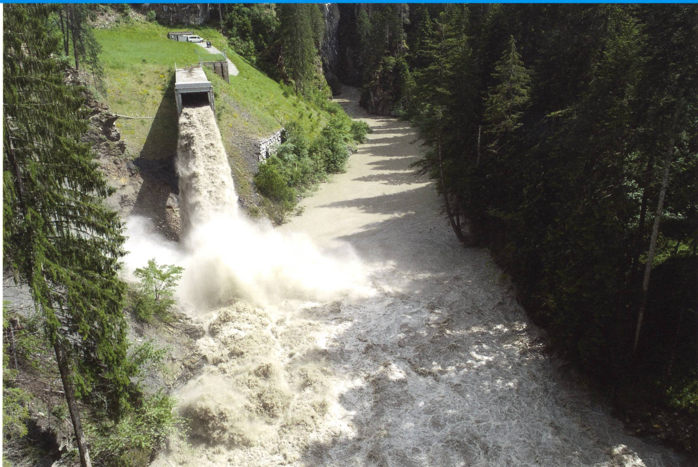
Les sédiments retournent dans l'Albula via la galerie de dérivation.
