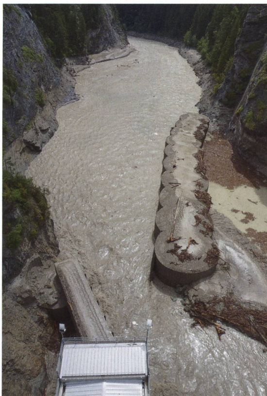
Entrée de la galerie de dérivation des sédiments (en bas à gauche, vue dans le sens inverse de l'écoulement de l'Albula).
