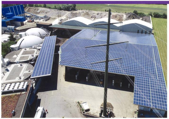
Eine PV-Anlage im Netz der AEW, bei der die Blindleistung geregelt wird, um das Netz zu stabilisieren.
