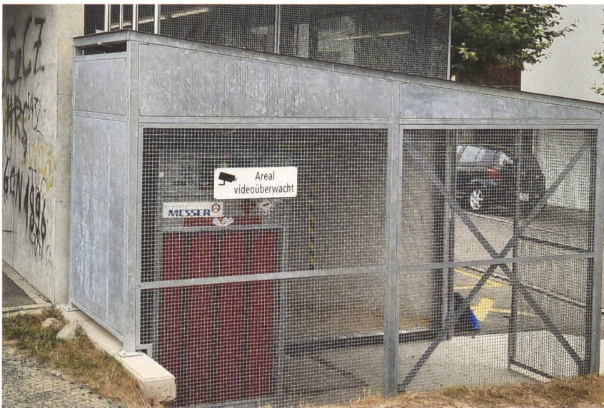
Bild 3 Aufstellung Wasserstoffzylinder zur Notstromversorgung.
