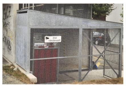
Bild 3 Aufstellung Wasserstoffzylinder zur Notstromversorgung.
