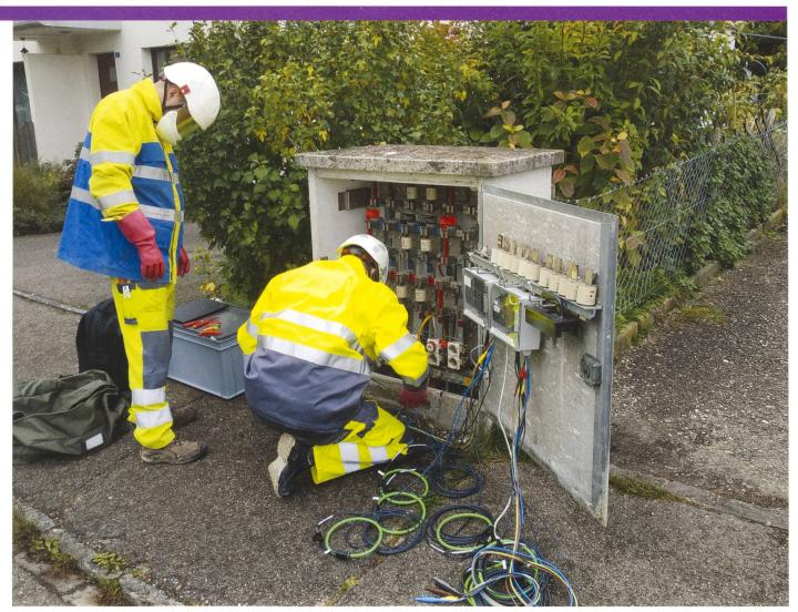
Installation der PQ-Messgeräte in einer Verteilkabine
