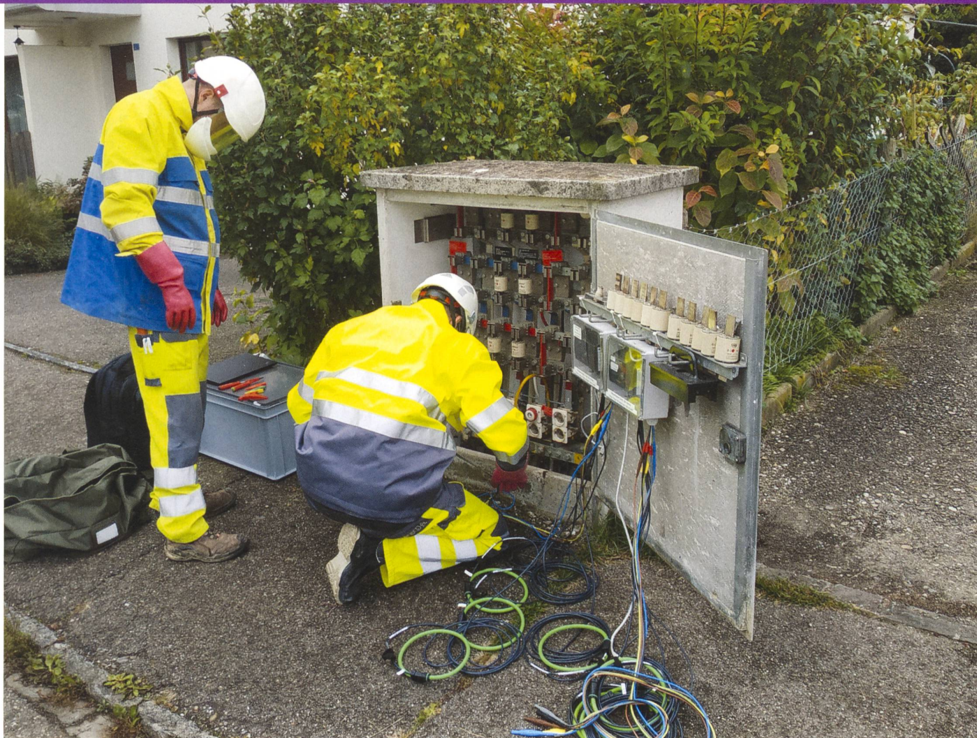
Installation der PQ-Messgeräte in einer Verteilkabine.
