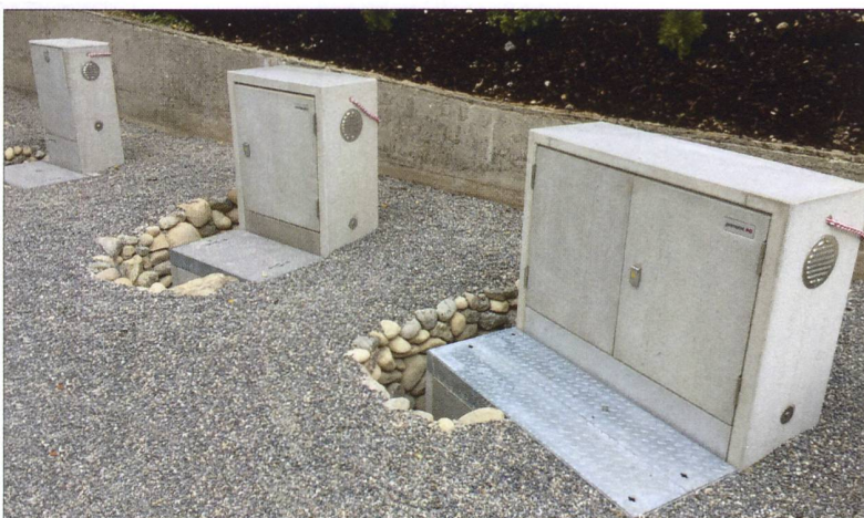
FILENIT Verteilnkabinen nach EN61439-5
