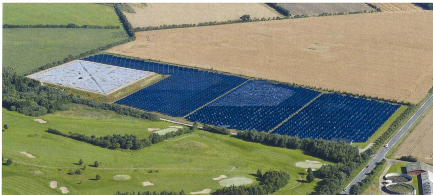
Bild 2 Erdbeckenspeicher in Toftund, Dänemark [5].
