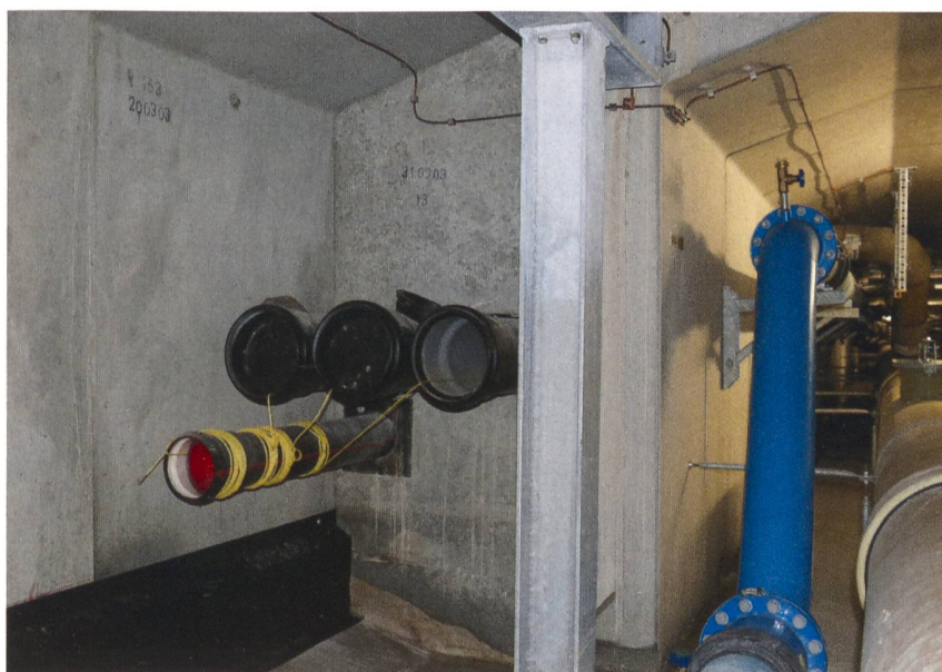
Die Kabel der neuen 220-kV-Leitungen verlaufen im Uetlibergtunnel unter der Fahrbahn. Sie werden in bereits erstellte Rohrböcke neben dem Werkleitungskanal eingezogen.
