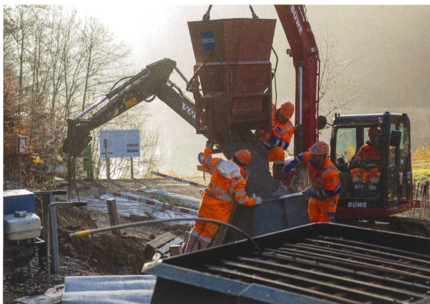
Bau der Mastfundamente beim Waldweiher.
