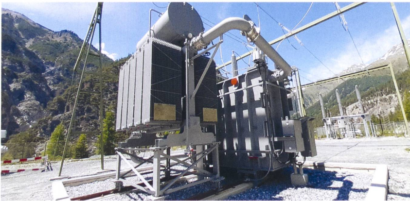
Bild 2 Variable Drosselspule mit AIS-Schalter im Betrieb (Ova Spin).
