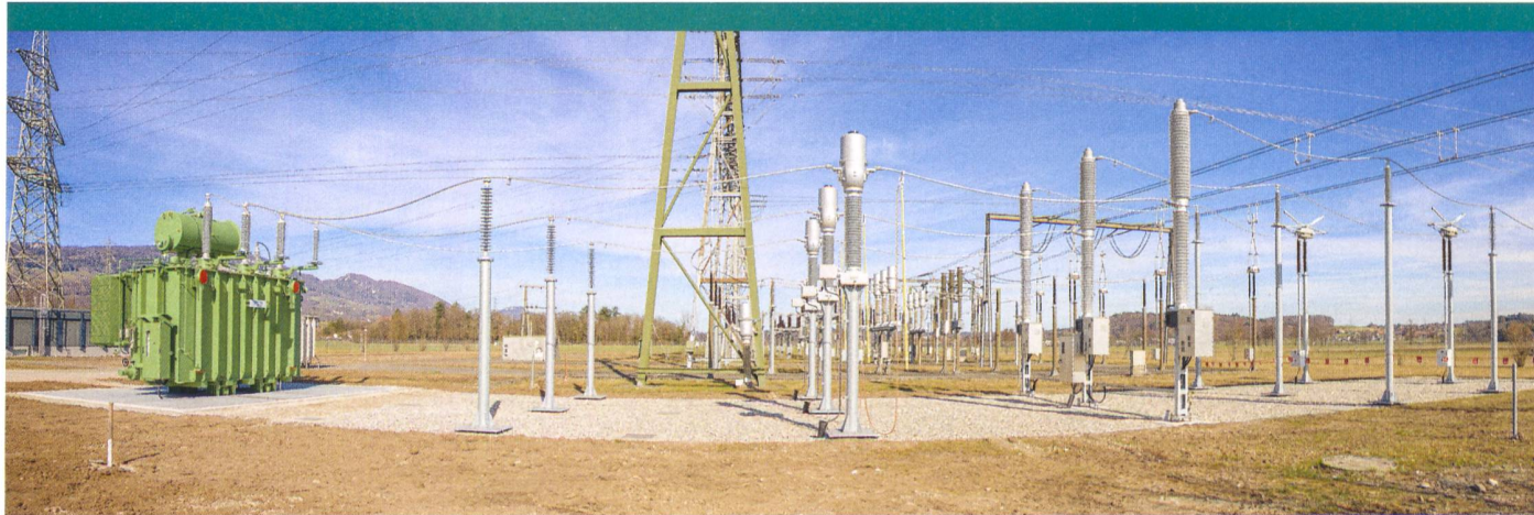
Installation mit Drosselspule, Kombiwandler und Leistungsschalter.
