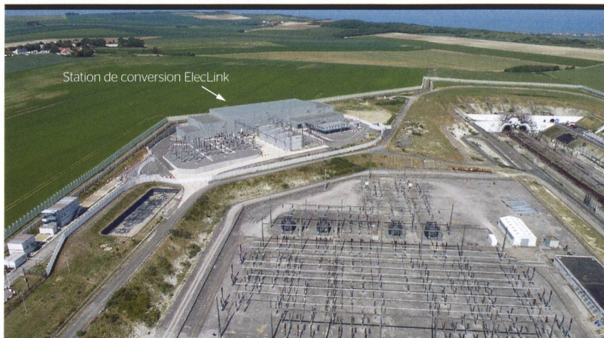
Figure 5 Réelle proximité des emprises ferroviaires de la station de conversion ElecLink et de la station d'alimentation principale du côté français du tunnel sous la Manche.
