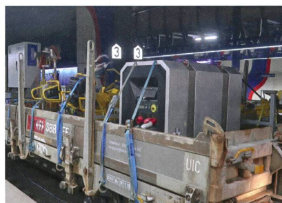
Einsatz des Butler S auf einer Bahnbaustelle.
