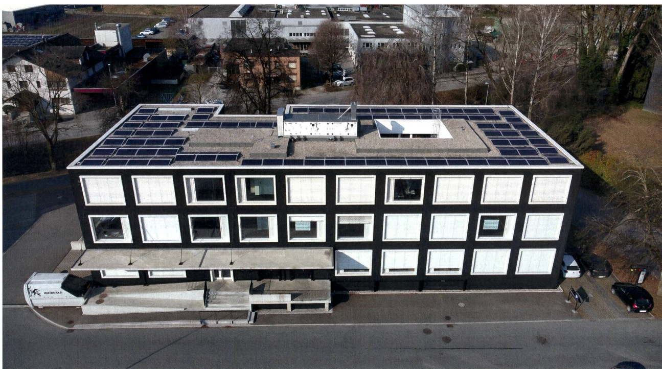
NeoVac hat das Gebäude der Walbusch Walter Busch AG fit in Sachen Energieeffizienz gemacht.
