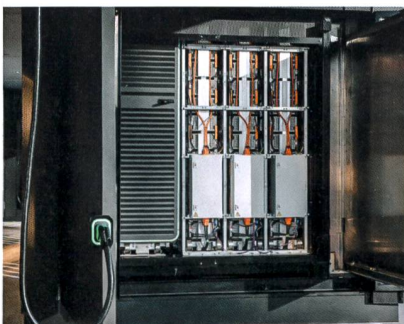
Powercube mit 198 Batteriemodulen (2 nd life).
