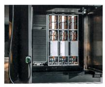
Powercube mit 198 Batteriemodulen (2<sup>nd</sup> life).
