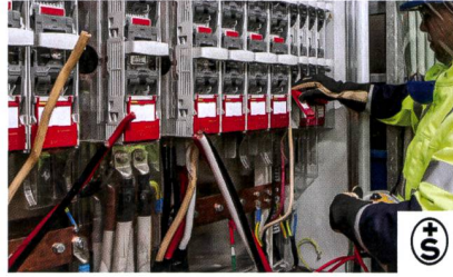
Lastschaltleisten Typ TRIVER+.
