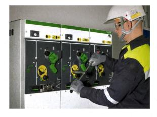
Le nouveau tableau de distribution moyenne tension sans SF<sub>6</sub> en version 12 ou 24 kV pour postes de boucles réseaux.
