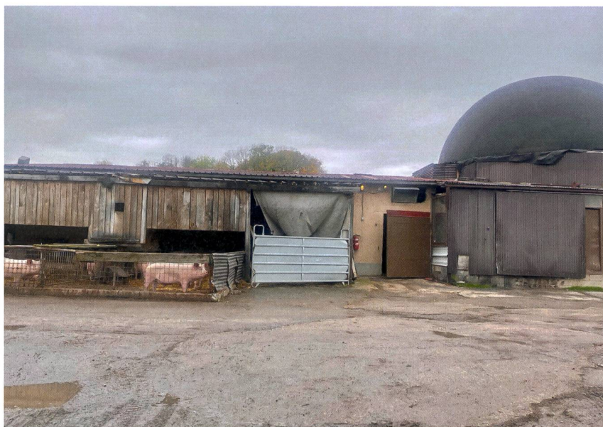
Centrale à biogaz de la famille Martin à Puidoux.
