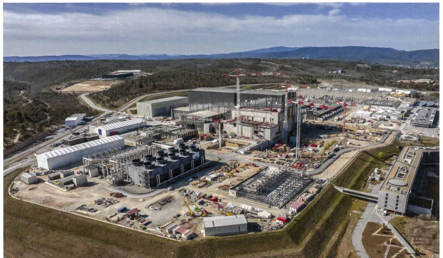
Des photos aériennes du chantier à Cadarache, dans le sud de la France, montrent l'avancement du projet. Celui-ci a toutefois connu des retards importants à maintes reprises par le passé.
